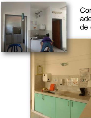
Con el fin de mejorar la funcionalidad en el área de enfermería, además de adecuar los espacios en cumplimientos a los principios de calidad y habilitación en salud en cuanto a las áreas de trabajo limpio y sucio, se realizaron trabajos de demolición, alzado de muros, repellones, estuco, entre otros.
